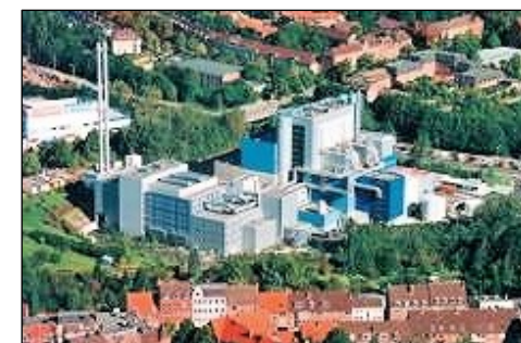
Endstation für Schmuggelzigaretten: Müllheizkraftwerk Kiel
